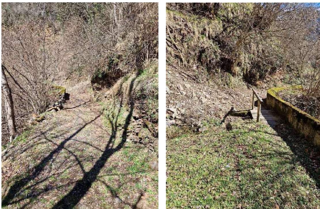
Imatge 2: El paviment és de terres, d'amplada variable entre 2 i 2,5 metres i en alguns punts l'amplada queda reduïda per l'acumulació de material. Petita palanca per vianants.
